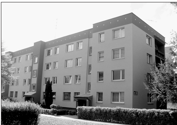
Nowa elewacja budynku przy ul. Armii Krajowej 51-55.
