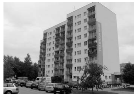
oraz z nową już elewacją
