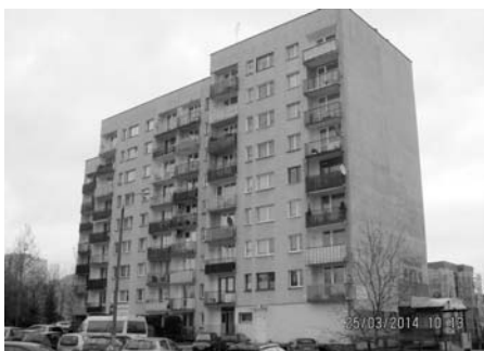
Blok przy ul. Tolstoja 60-62 - przed remontem
